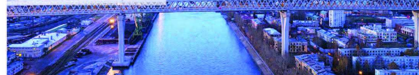
Мост через Морской канал
