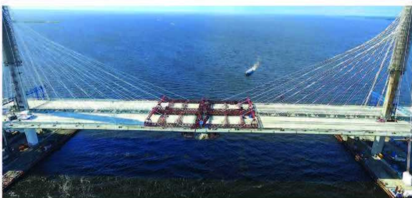
Смычка моста через Петровский фарватер
